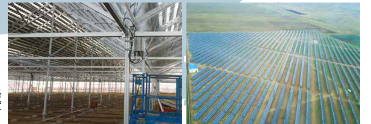
発電容量12.7MWの大規模太陽光発電所。発電所の一部では、背の高い高架を使用してソーラーシェーディングを実施。農作物の収穫も行う。
