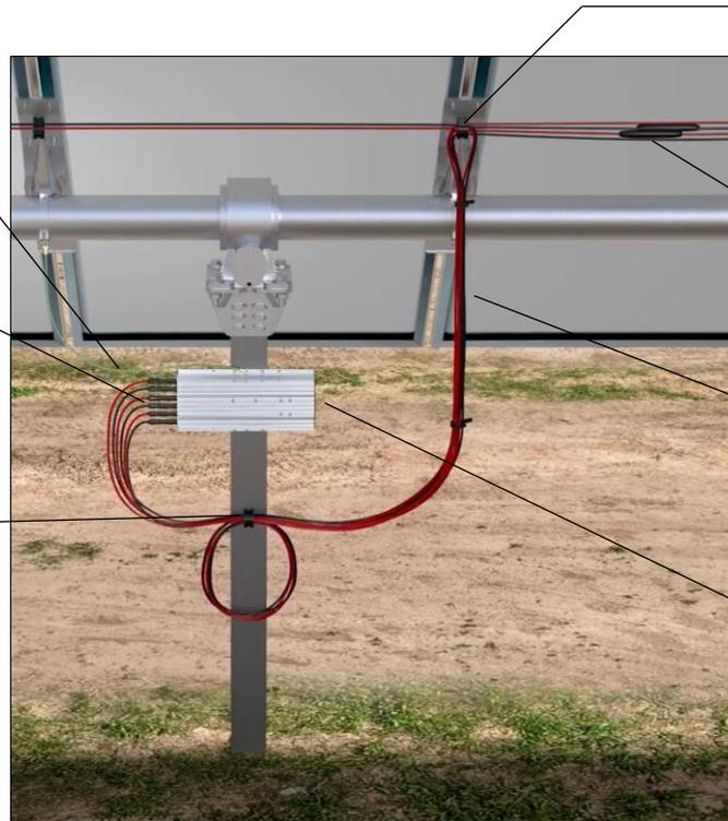
ワイヤが摩耗しないように、ケーブルクリップを使用してワイヤをトラッカーテーブルに固定してください。
